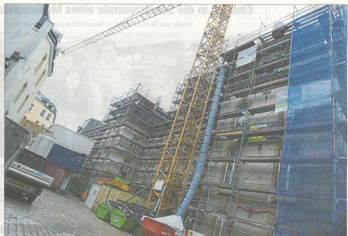
Nachdem der Justizpalast im Jahr 1886 durch ein Feuer schwer beschädigt worden war, entwarf Staatsarchitekt Charles Arendt die neue Fassade, wobei zugleich die bebaute Fläche vergrößert wurde.
