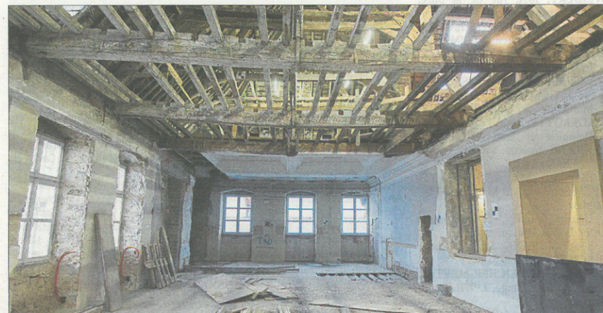
Das Dachgebälk, dessen Holz aus verschiedenen Jahrhunderten stammt, ist gut erhalten und soll durch eine teilweise offene Decke hervorgehoben werden.
