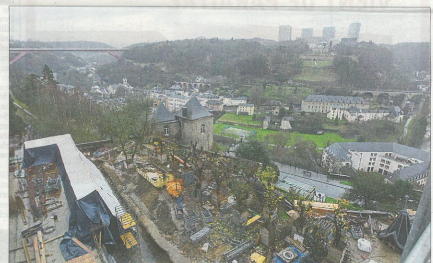
Beneidenswert: Vom ehemaligen Justizpalast aus bietet sich eine fantastische Aussicht. Der Garten wird nach den Bauarbeiten wieder instand gesetzt.
