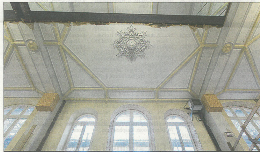
Im historischen Teil des Gebäudes sind die Mauern und Bodenplatten in gutem Zustand und werden dort, wo es nötig ist, verstärkt.
