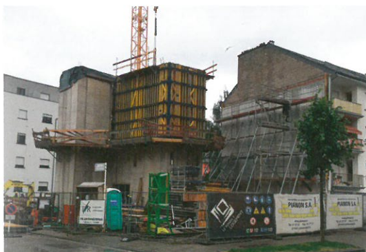
gross œuvre terminé
