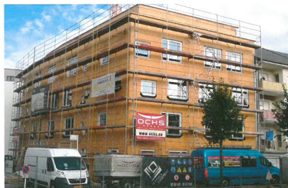
charpente bois terminé
